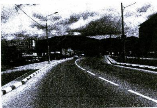
Реконструкция дорожного покрытия
