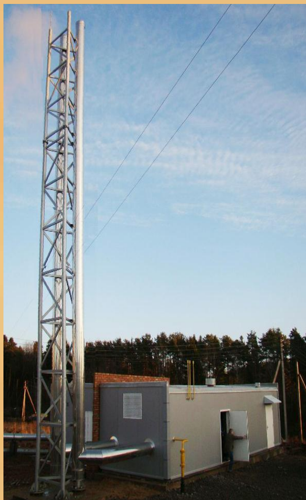
Котельная в дер. Пехенец
